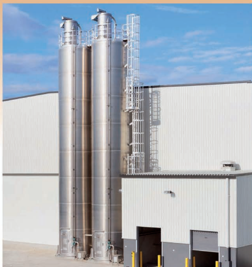
■ Silos extérieurs Aluminium/Inox
